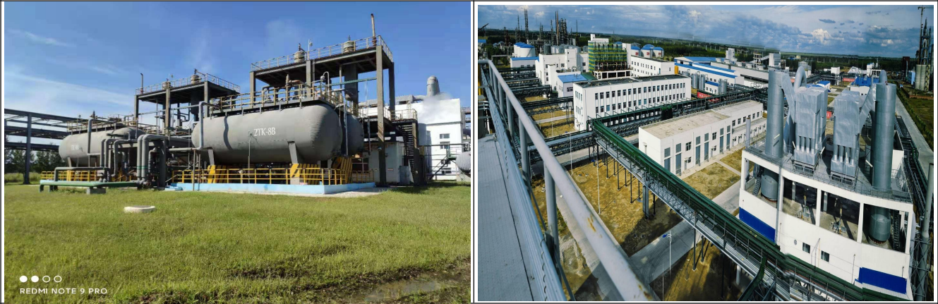
聚氯乙烯生产装置及全貌
