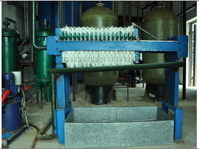
含汞废水处理单元污泥压滤系统
